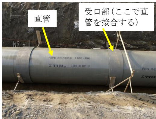
写真1 FRPM 管の接合状況
