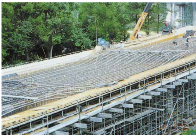
長野県、角間橋
