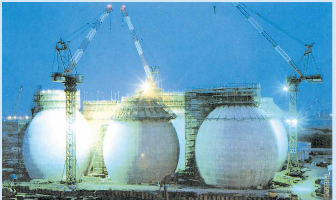
横浜市(北部第二下水処理場) わが国初のPC卵型タンク、高さ34m、直径max22m、容量6,800m 3 ×6基
