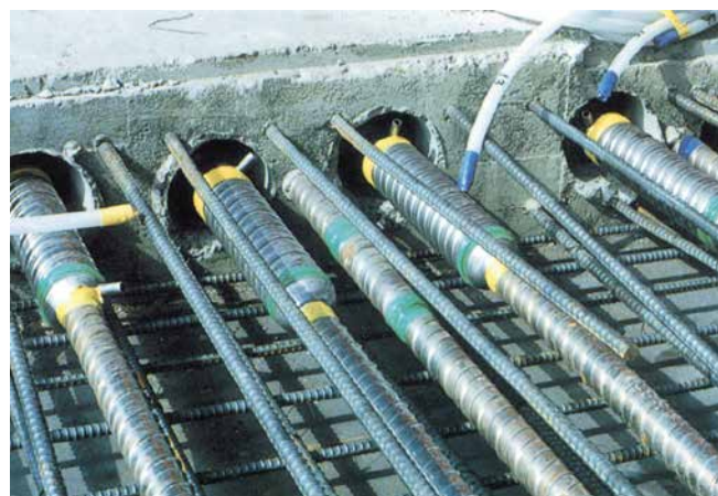
ディビダーク工法施工例
