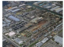
加賀屋工場航空写真
