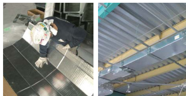
軽いので容易に作業できます 施工済みのダクト
