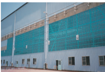
大阪臨海工場壁面の明かり取り
