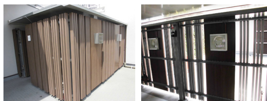
コロナウイルス感染予防対策(目隠し板の間隔を広げ、換気扇設置)
