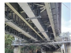
主桁・床版一体型FRP検査路
