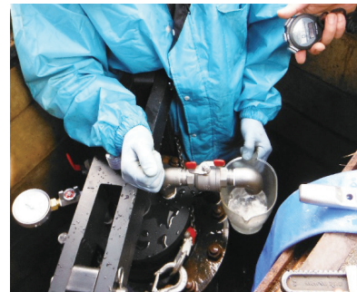
図6 現地漏れ量測定状況
