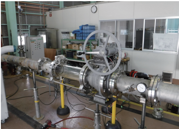
図10 実流試験状況
