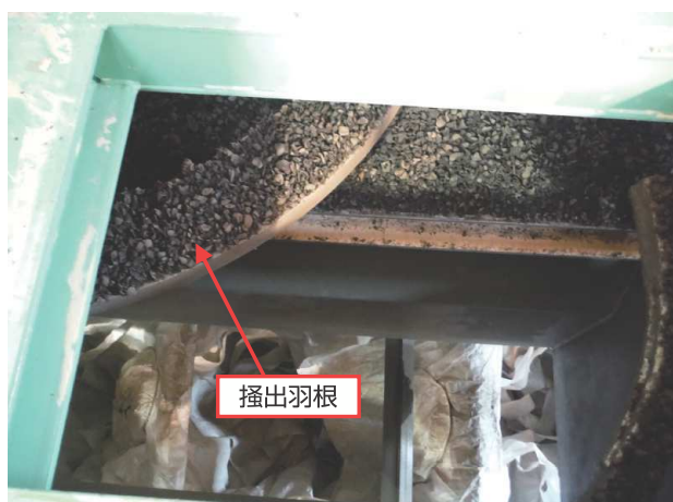
図19 PKS 運転停止直後（上方より撮影）
