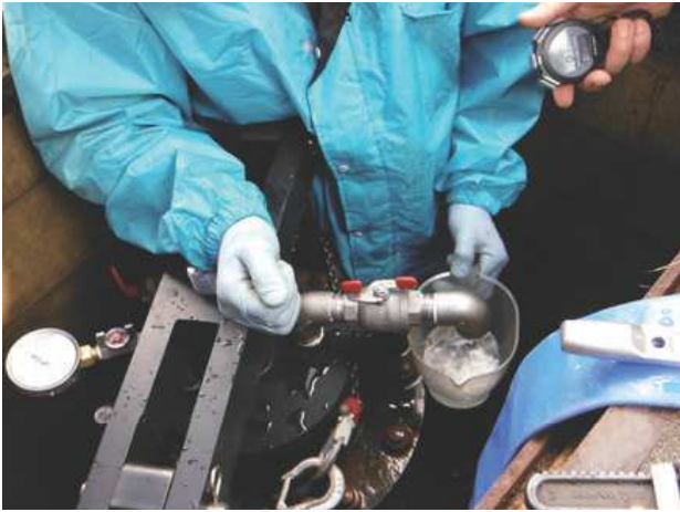
図6 現地漏れ測定状況
