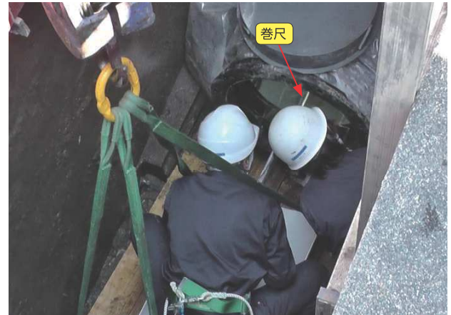
図14 挿入距離確認作業
