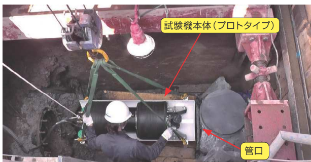
図13 フィールド実験状況
