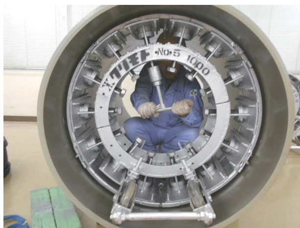
図1 テストバンド組立作業状況 (呼び径1000)
