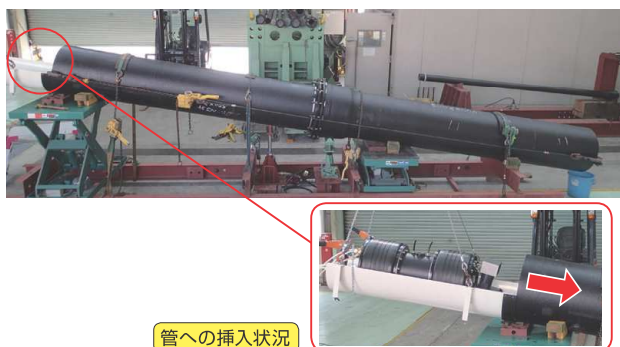
管への挿入状況
