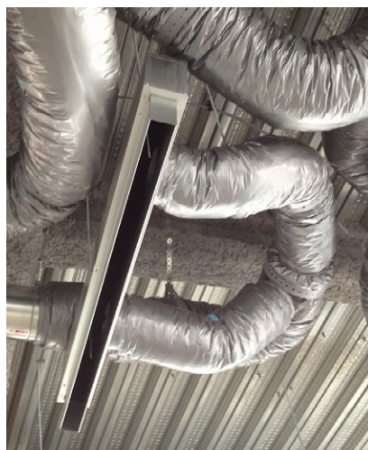
図2 保温フレキシブルダクト施工状況（最下流）
