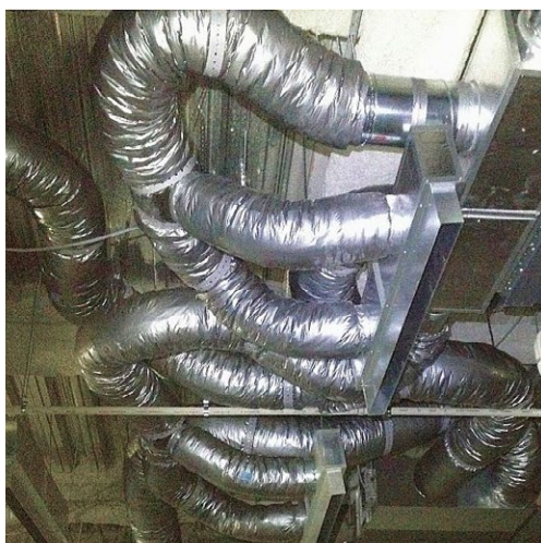
図1 保温フレキシブルダクト施工状況
