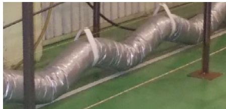
図7 たわみによる圧力損失試験状況
