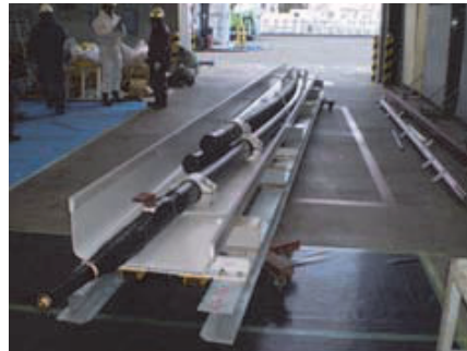
図9 ケーブル敷設
