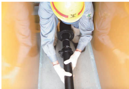
図7 直管の施工性試験状況
