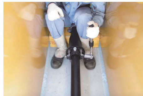
図8 抜け止め押輪の施工性試験状況
