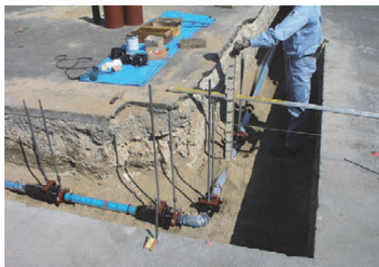
図38 管路布設状況
