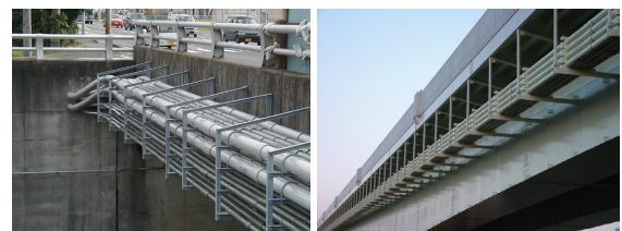
図1 電力用ケーブル保護管設置例
