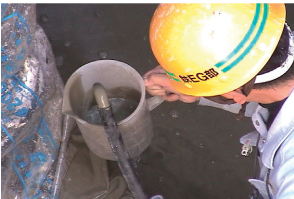
図24 オーバーフローした充填材の採取状況(到達立坑側)
