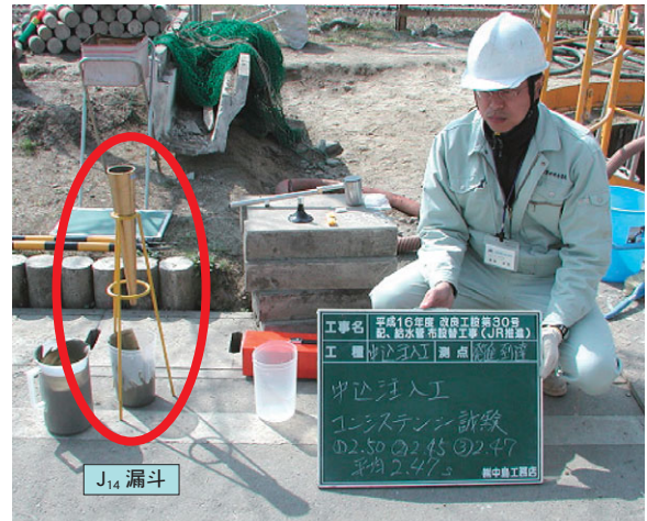
図21 コンシステンシー試験
