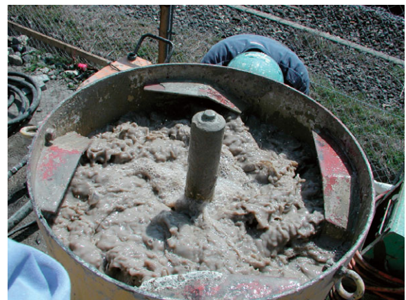
図18 流動化材スラリー混練状況
